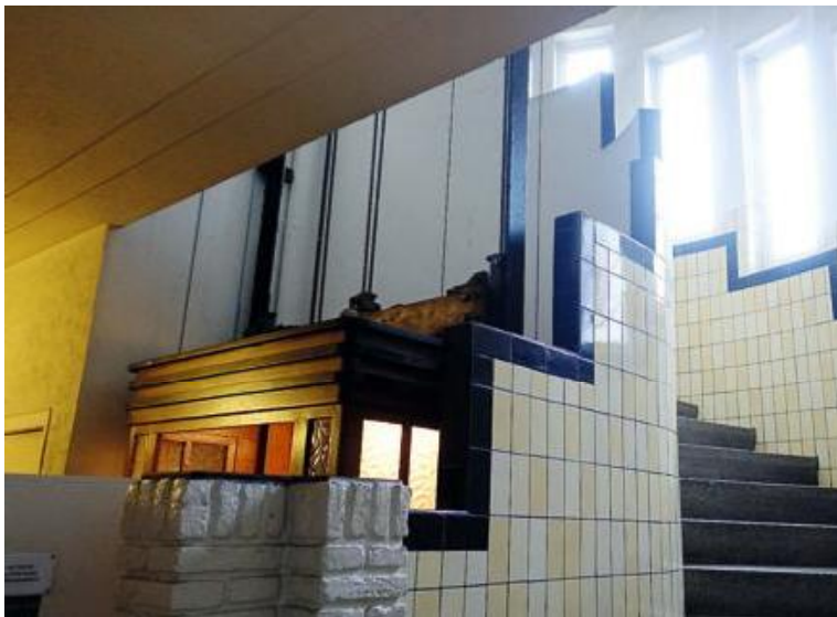
Cet ascenseur de l'avenue Molière est classé. Les propriétaires se demandent ce qu'il deviendra entre exigences bruxelloise (le classement) et fédérale (la sécurité des ascenseurs).
