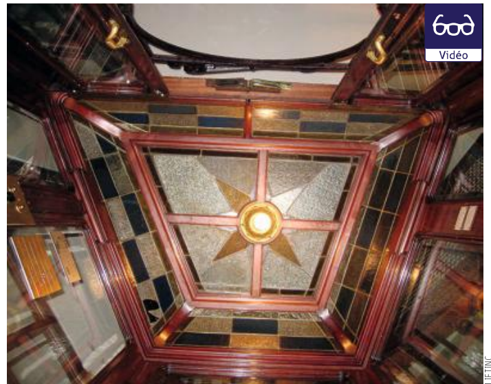
Les cabines sont également visées par la loi. Comme celle-ci dont le plafond risque de devoir passer au plexiglas et se voir affubler d'un second point lumineux de secours.
