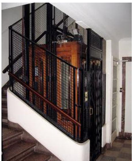
L'avant-après de la mise en conformité d'un ascenseur datant des années 1960. Le grillage d'origine a été doublé par un treillis plus élevé aux mailles plus fines. La porte coulissante en fer forgé a, par contre, dû être remplacée.
