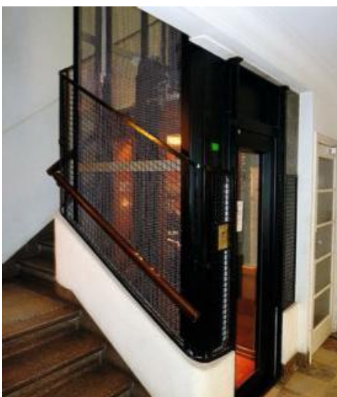
L'avant-après de la mise en conformité d'un ascenseur datant des années 1960. Le grillage d'origine a été doublé par un treillis plus élevé aux mailles plus fines. La porte coulissante en fer forgé a, par contre, dû être remplacée.
